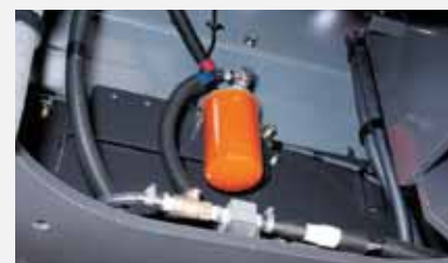
Точки контрольного осмотра, расположенные за нижним кожухом
